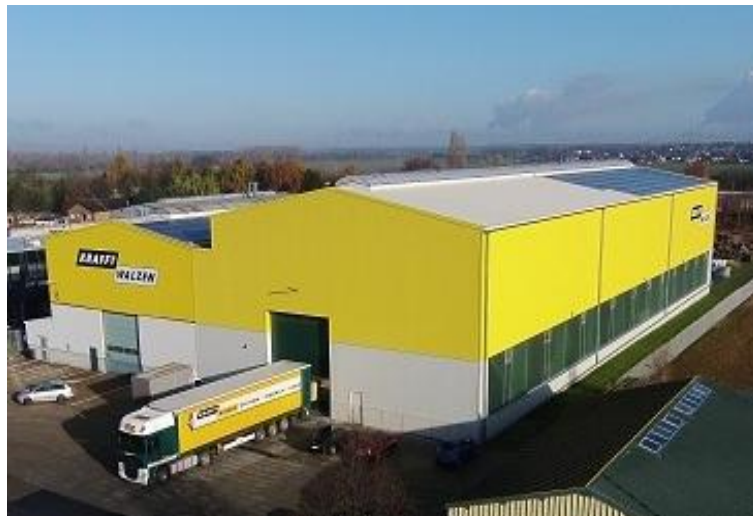
Das Bild zeigt den Erweiterungsbau in Werk 2 in der rechten Bildhälfte.
